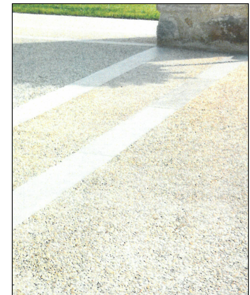
NUOVA PAVIMENTAZIONE IN FAVETTO CEMENTATO
